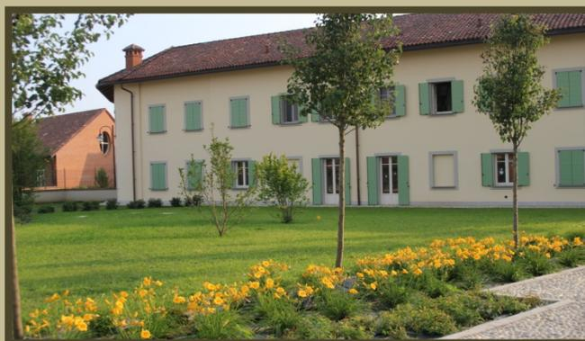
**Il ripristino delle facciate con le caratteristiche cornici alle finestre, gli antelli ciechi in legno, le soglie e le zoccolature in pietra naturale, riportano all'origine l'aspetto esterno degli edifici grazie anche alle coperture realizzate in coppi antichizzati, integrati con quelli esistenti recuperati.**
